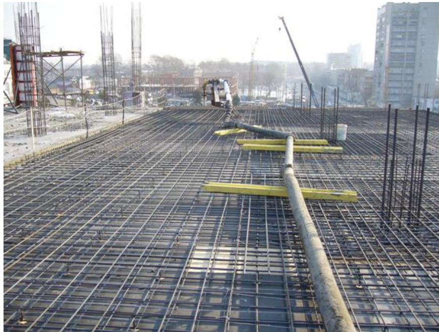
Мал. 3. Електропрогрів бетону
